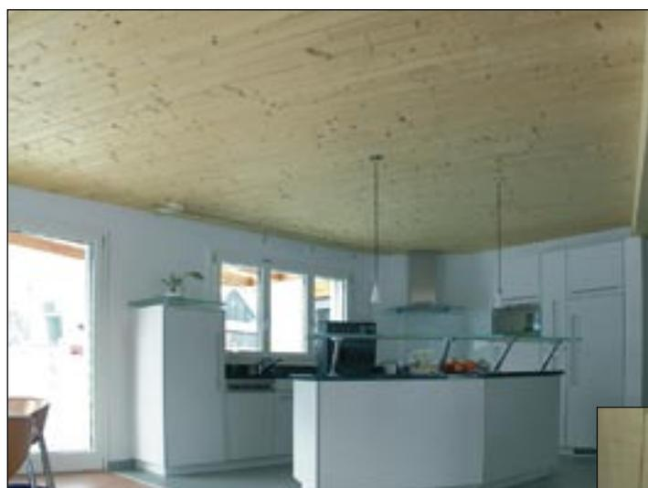
Una casa en la Suiza. Techo prefabricado de Tablones de techo Schneider. Su cara inferior (vista) puede tratarse con color o dejarse en óptica natural.
