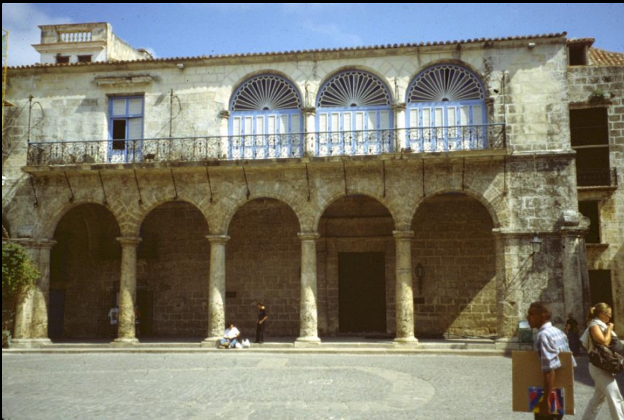
Casa de los Marqueses de Arcos, 1740
